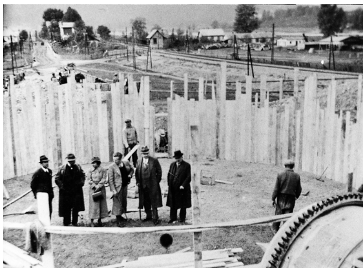
Obr. 2. Prvé výkopové práce. (Zdroj: Archív Vlastivedného múzea v Považskej Bystrici).
