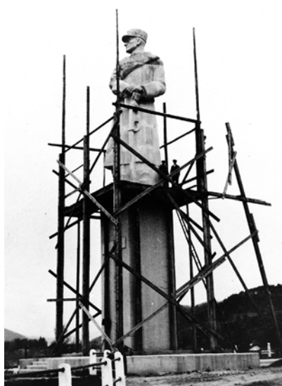
Obr. 4. Postavenie lešenia. (Zdroj: Archív Vlastivedného múzea v Považskej Bystrici).
