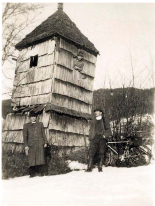
Obr. 2 Pôvodný jednoduchý prístrešok - zvonica.
