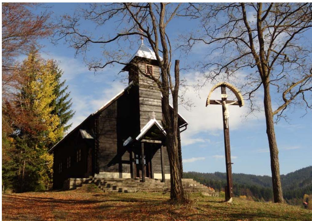
Obr. 9 Celkový pohľad na kostolík (snímka z 15. októbra 2015).
