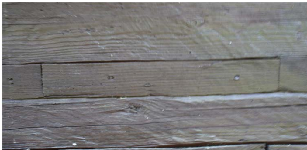
Obr. 8 Pripevnený „skulník“ medzi brvnami domu; Horná Mariková – Rovné. Foto: P. Rágulová, 2016
