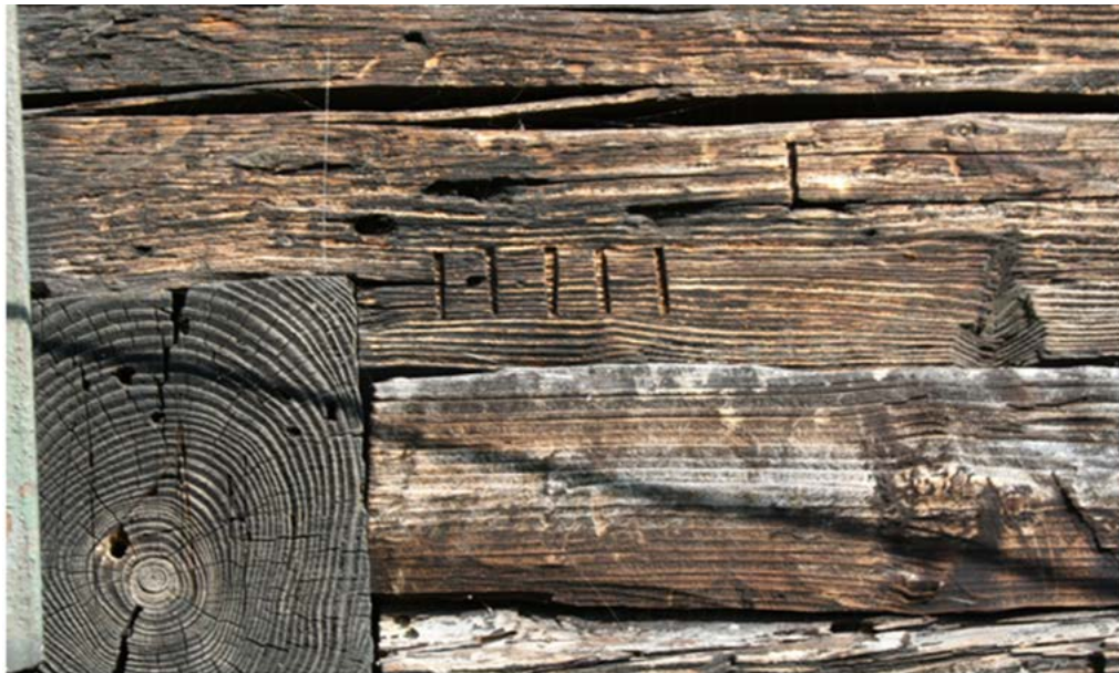
Obr. 10 Označovanie obvodových brvien rímskymi číslicami ako pomôcka pri premiestňovaní celej stavby drevenice; Horná Mariková – Rovné. Foto: P. Rágulová, 2016
