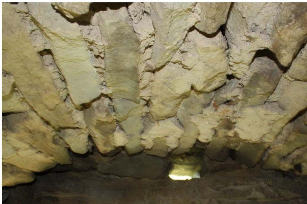
Obr. 5 Detail klenbovej kamennej pivnice s vetracím otvorom, Horná Mariková – Rovné. Foto: P. Rágulová, 2016
